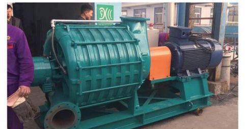
山东圣泉施工现场 Shandong Shengquan construction site
